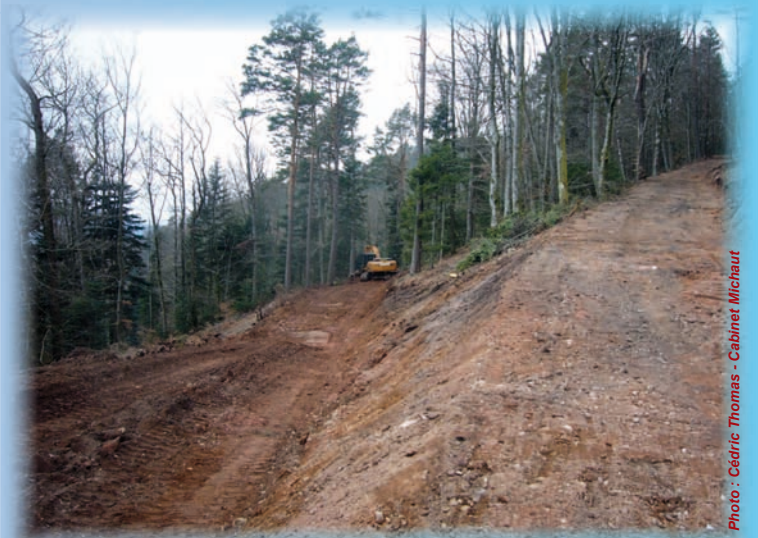
Terrassements sur la route de l'Ancerf à Faucompière (massif vosgien)
