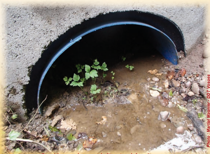
Demi-buse préservant le lit naturel du ruisseau
